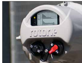
Fig. 4.2.1 IQT3 Lokale kontrollere
